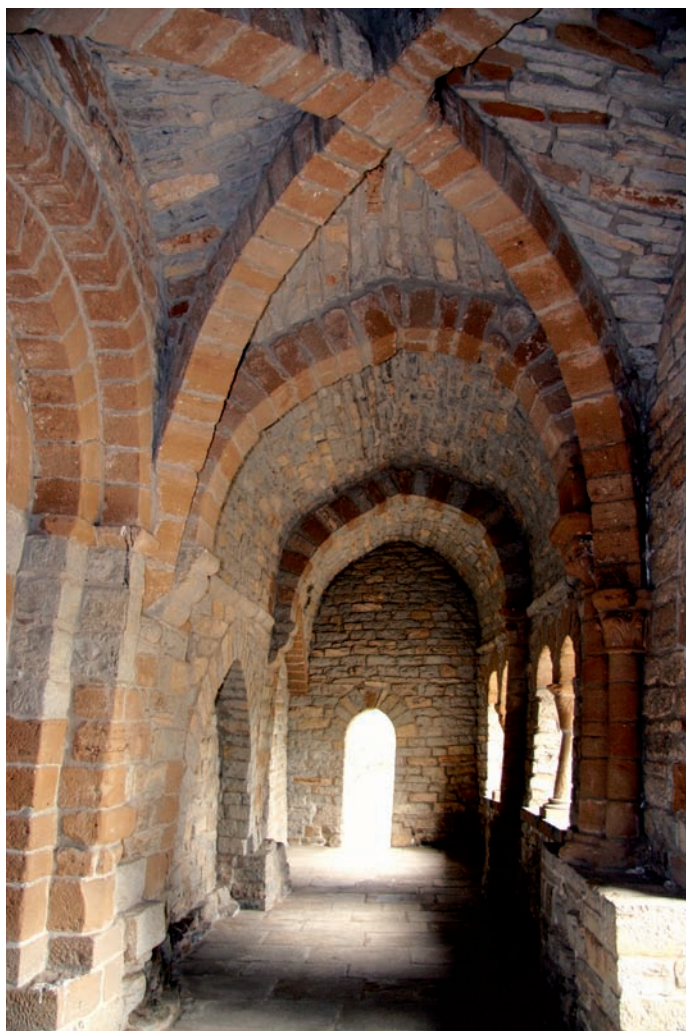
Interior del pórtico
