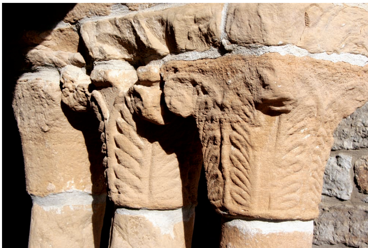
Capiteles del pórtico
