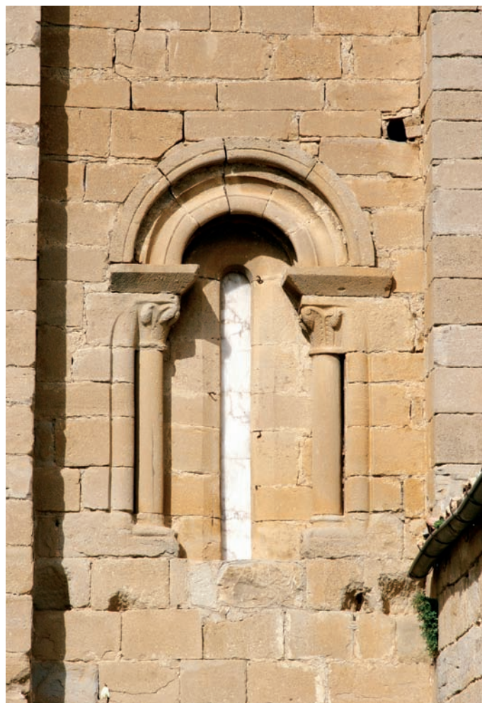
Ventana del muro sur
