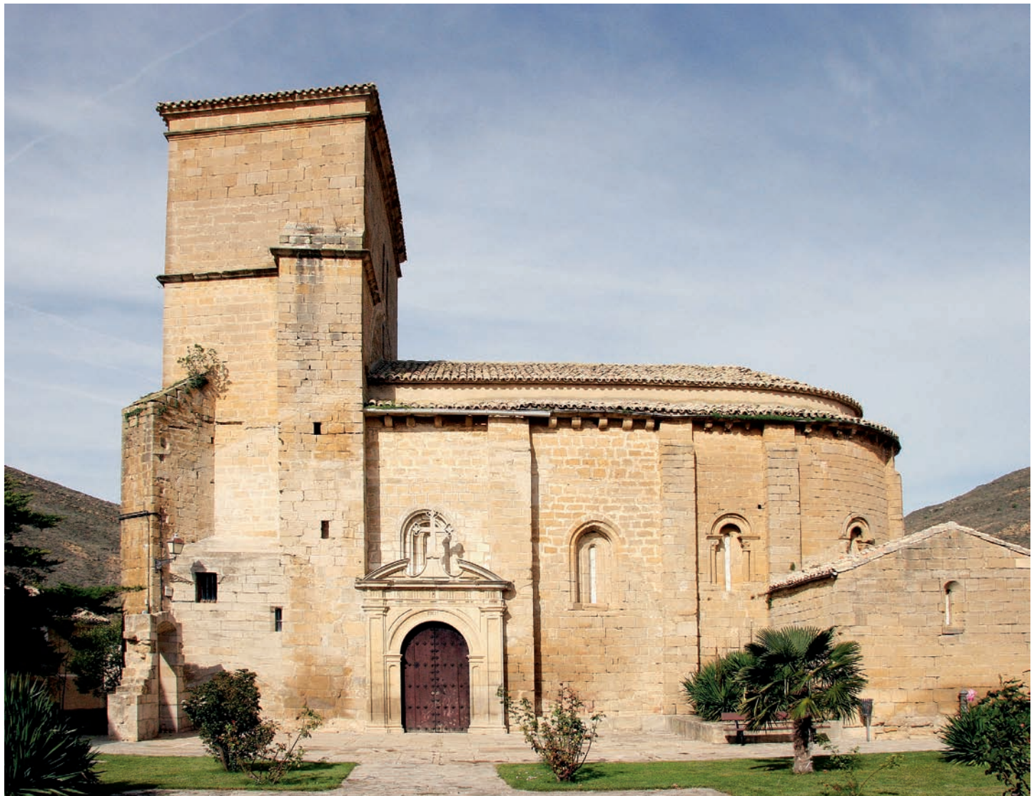
Exterior. Lado sur
