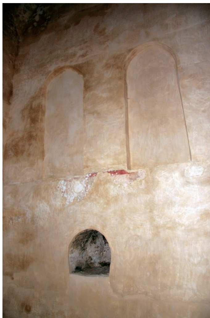
Muro septentrional del tramo con cúpula
