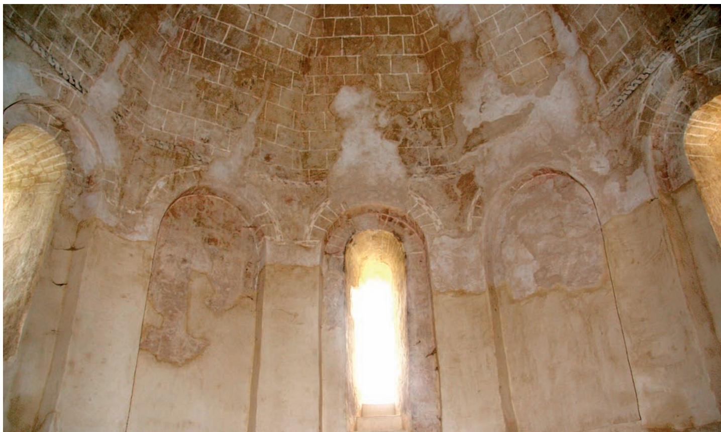
Interior del ábside
