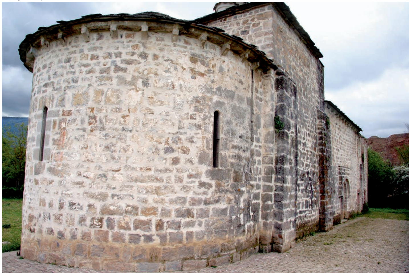
Ábside y muro septentrional
