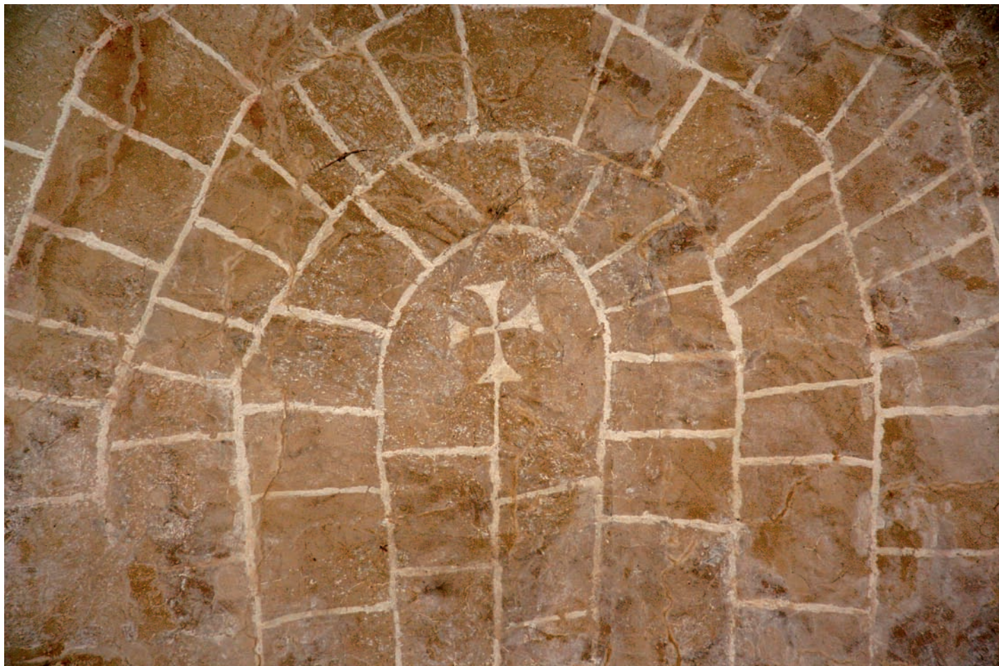
Detalle de la bóveda del ábside
