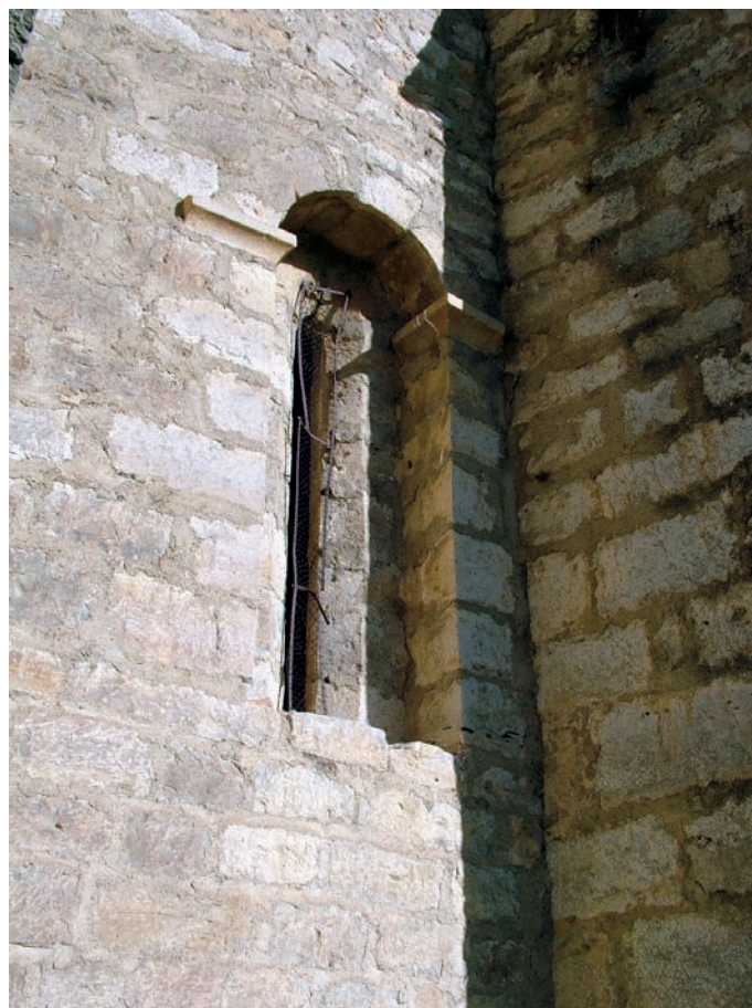
Ventana del muro sur
