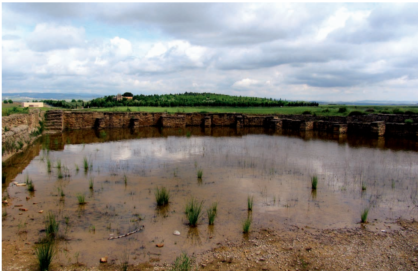
Restos del depósito de agua del poblado romano de Andelos
