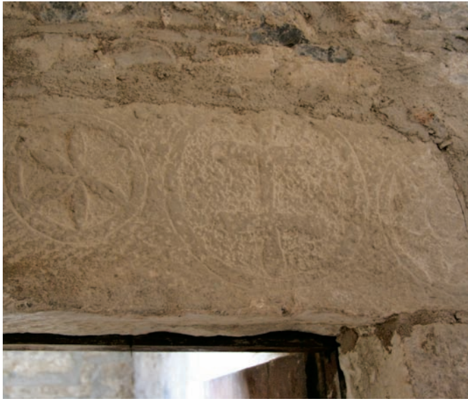
Restos de un antiguo tímpano románico reutilizado como dintel de la portada lateral
