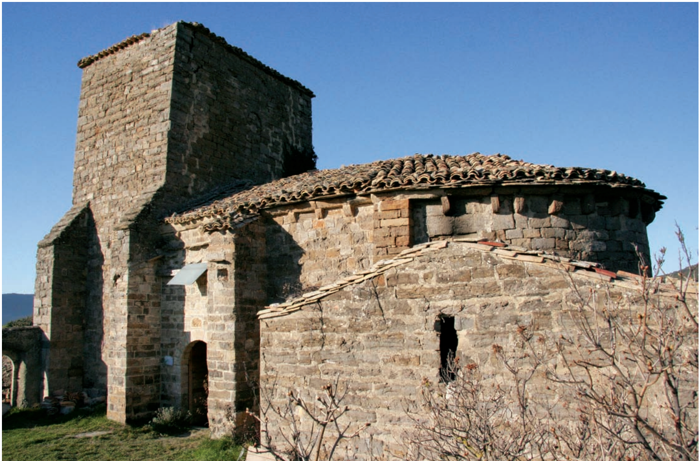
Exterior de la iglesia de San Martín de Tours. Vista general del frente sur
