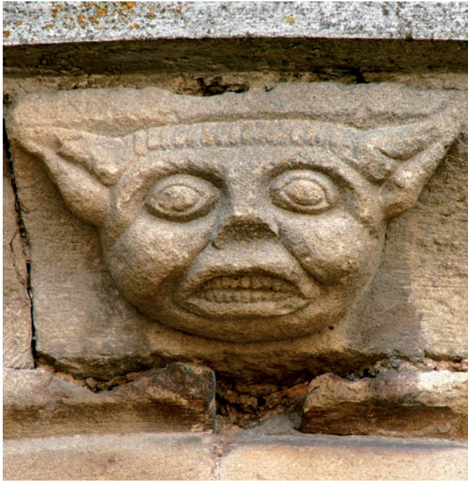
Detalle del guardalluvias
