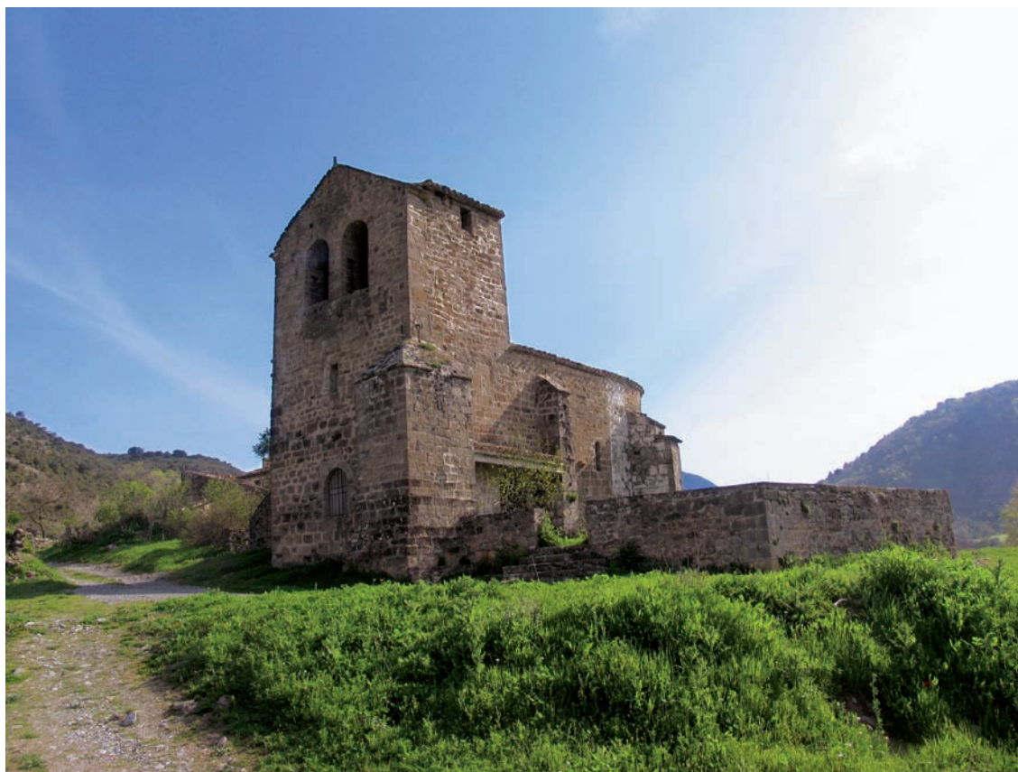
Vista desde el lado suroeste
