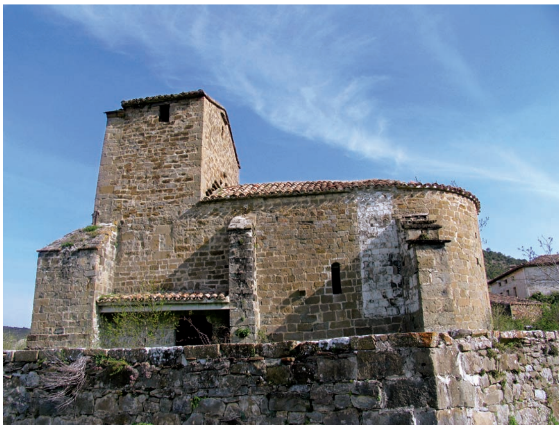
Vista desde el lado sur
