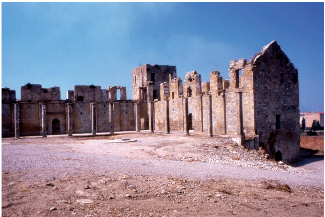
Palacio Real. Vista de las dos naves desde el patio
