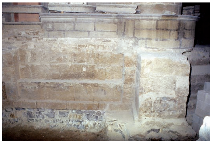
Cimentación y arranque del muro meridional de la capilla mayor de la catedral románica descubiertos en las excavaciones de 1992-1993
