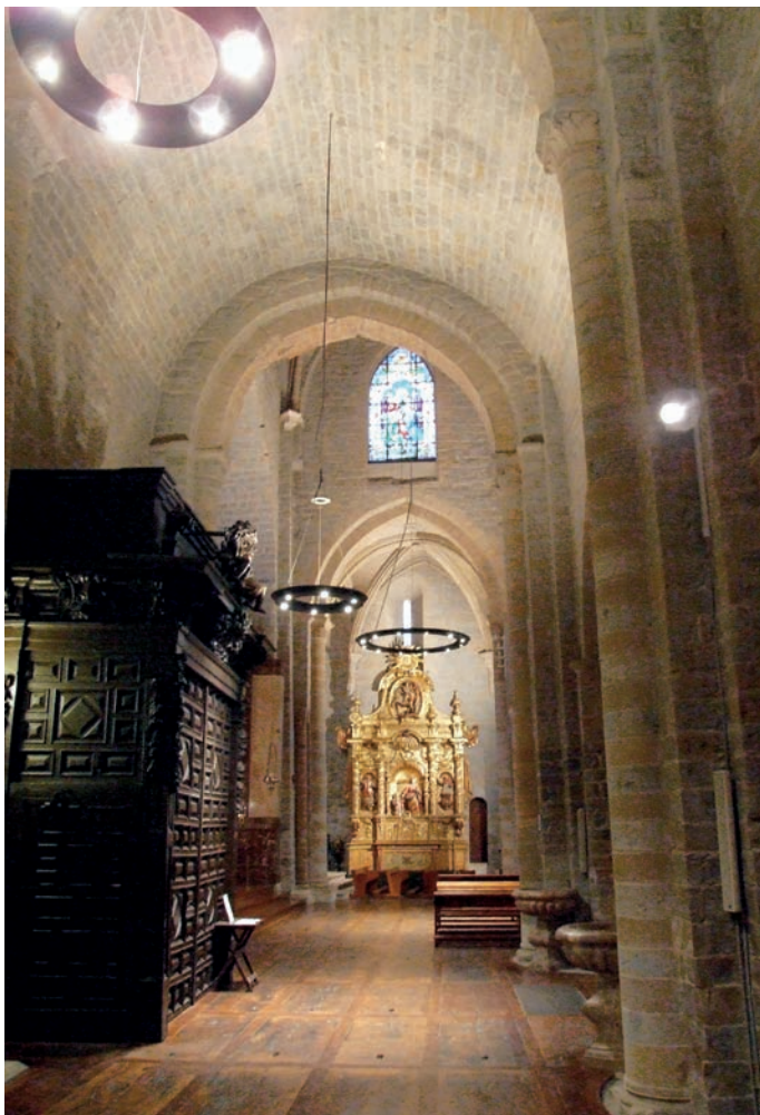
Interior de la nave septentrional
