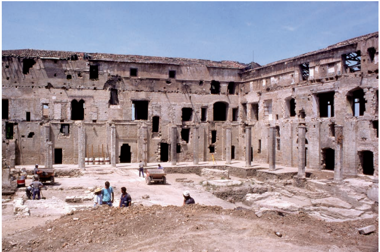
Obras en el Palacio Real (1995)
