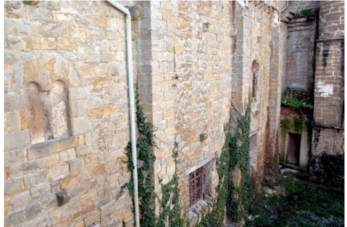
Otro aspecto del muro norte del antiguo palacio episcopal
