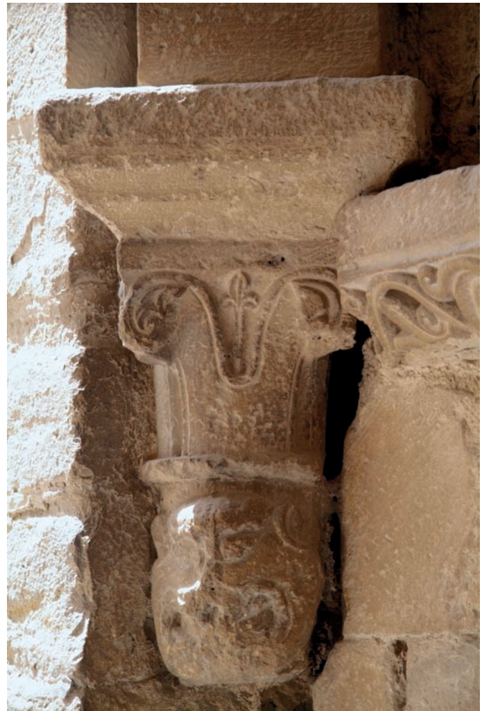
Capitel-ménsula del pórtico
