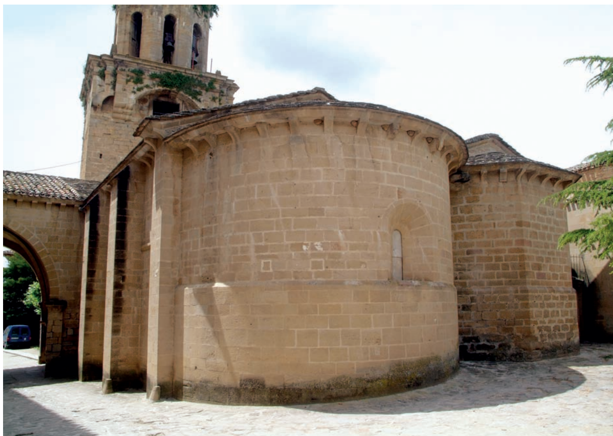
Exterior desde el lado este
