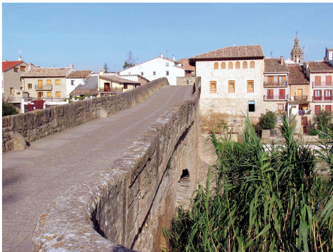
Calzada del puente
