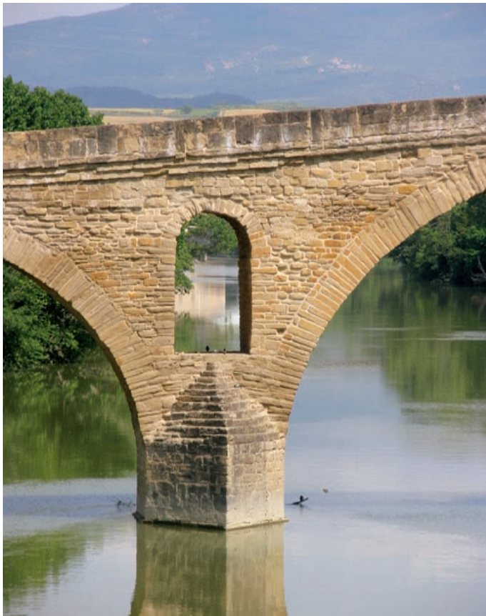
Detalle del aliviadero
