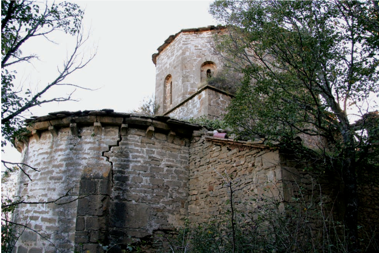
Exterior desde el lado norte
