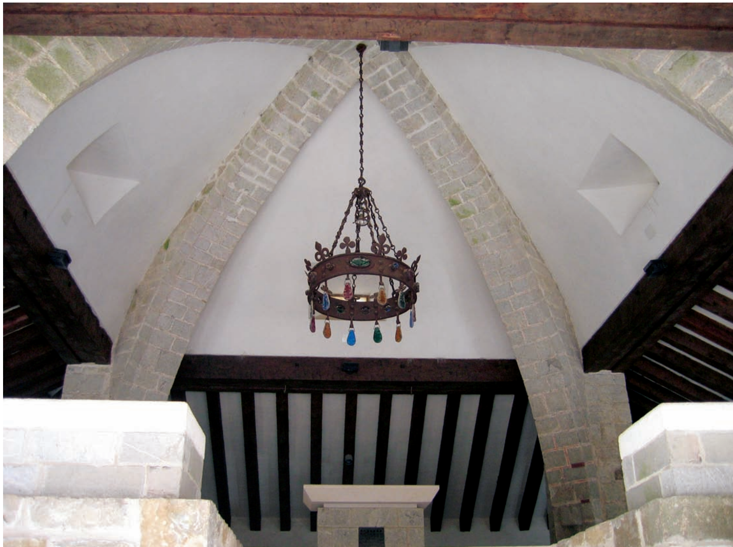
Interior de la capilla del Espíritu Santo
