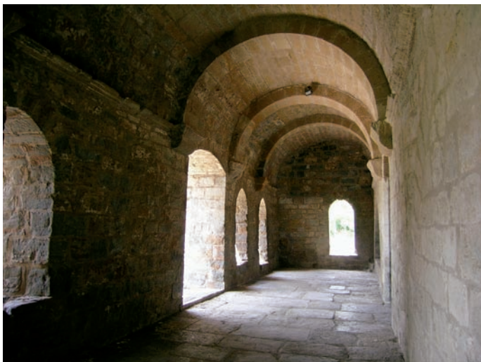
Interior del pórtico
