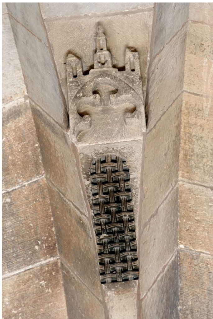
Ventana de la bóveda con celosía
