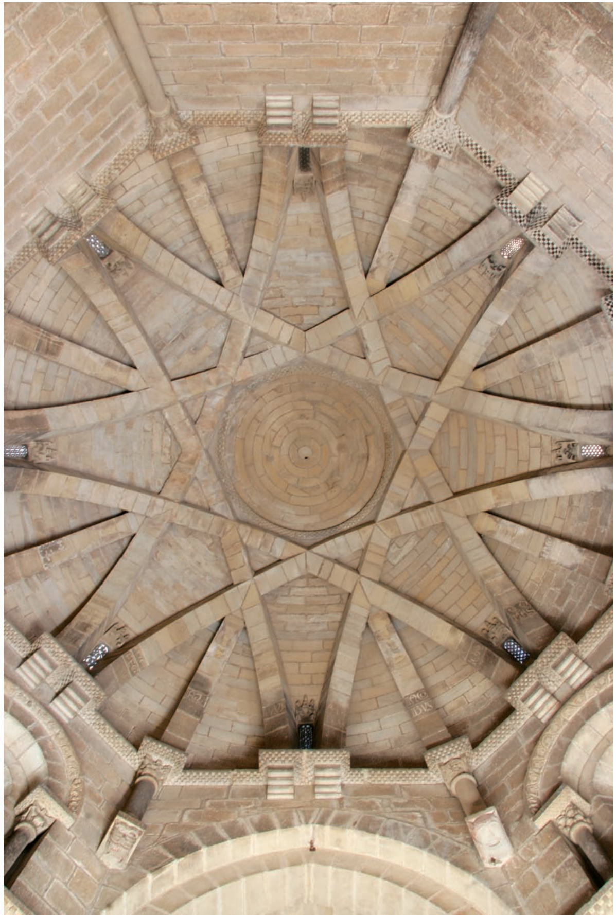
Vista general de la bóveda
