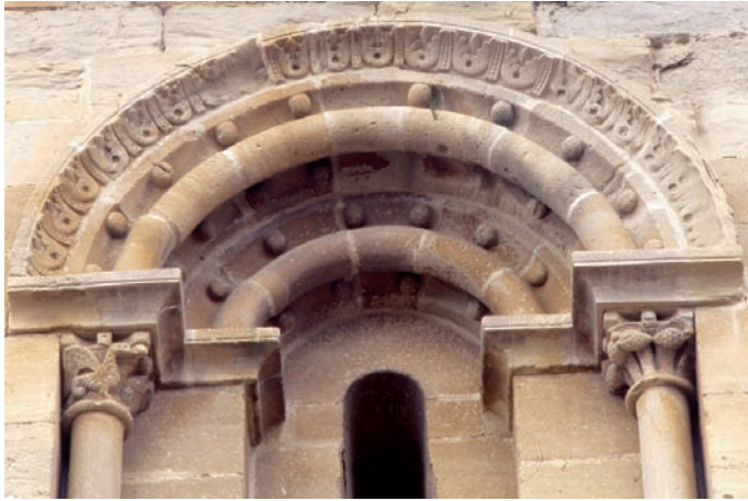
Detalles de las ventanas
