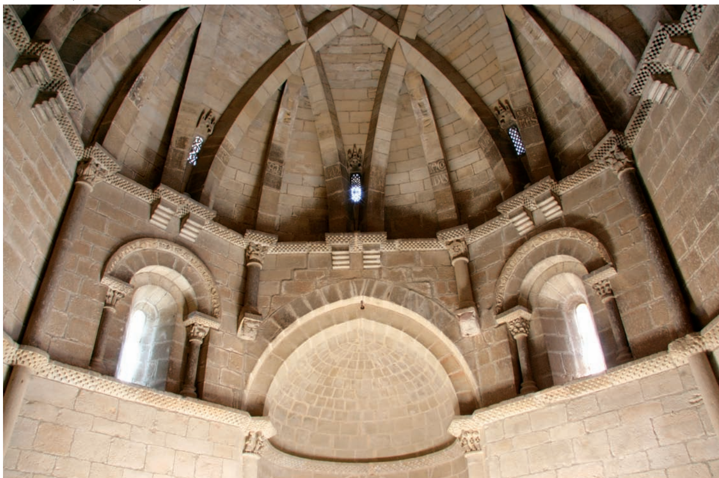
Detalle del arranque de la bóveda y ventanas
