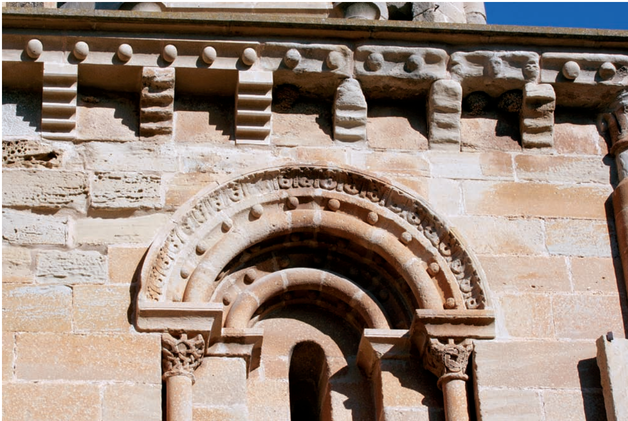
Detalle de una ventana y de los canecillos
