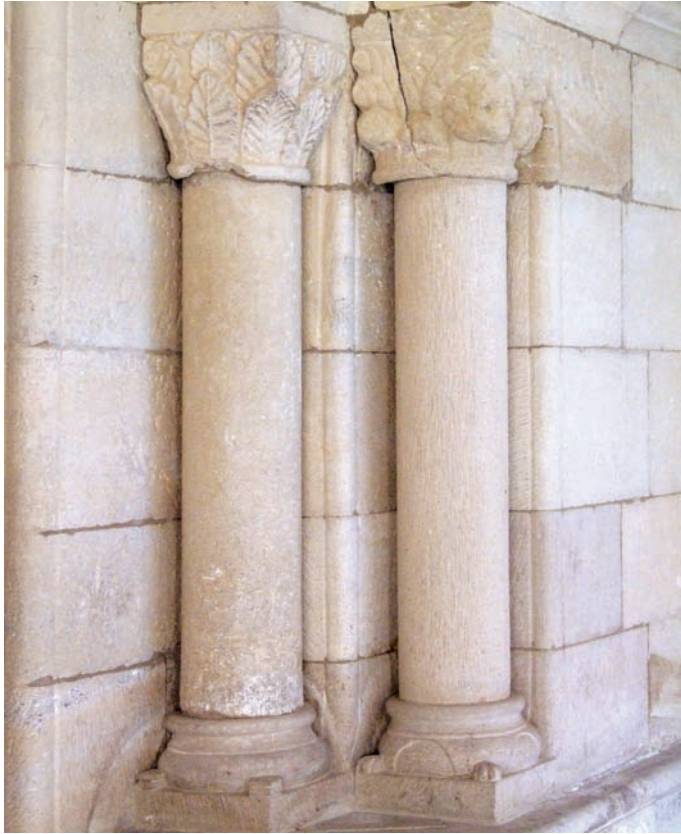
Detalle de la puerta sur
