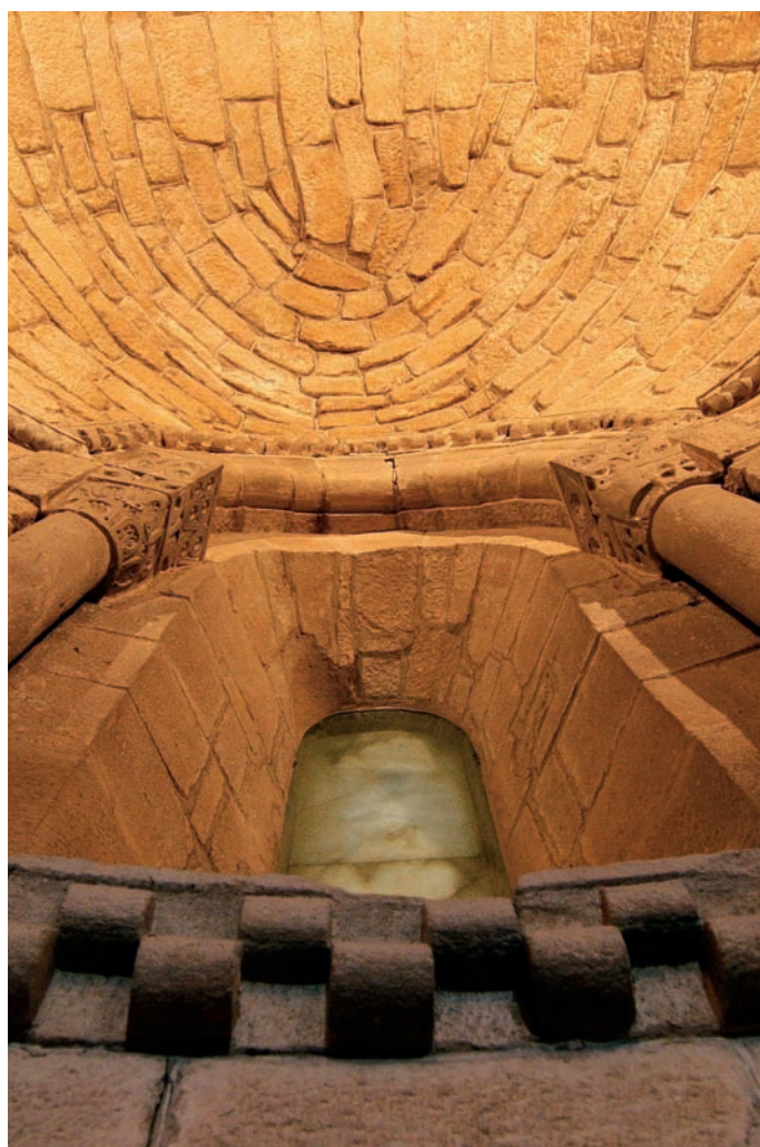
Detalle de la ventana del ábside septentrional
