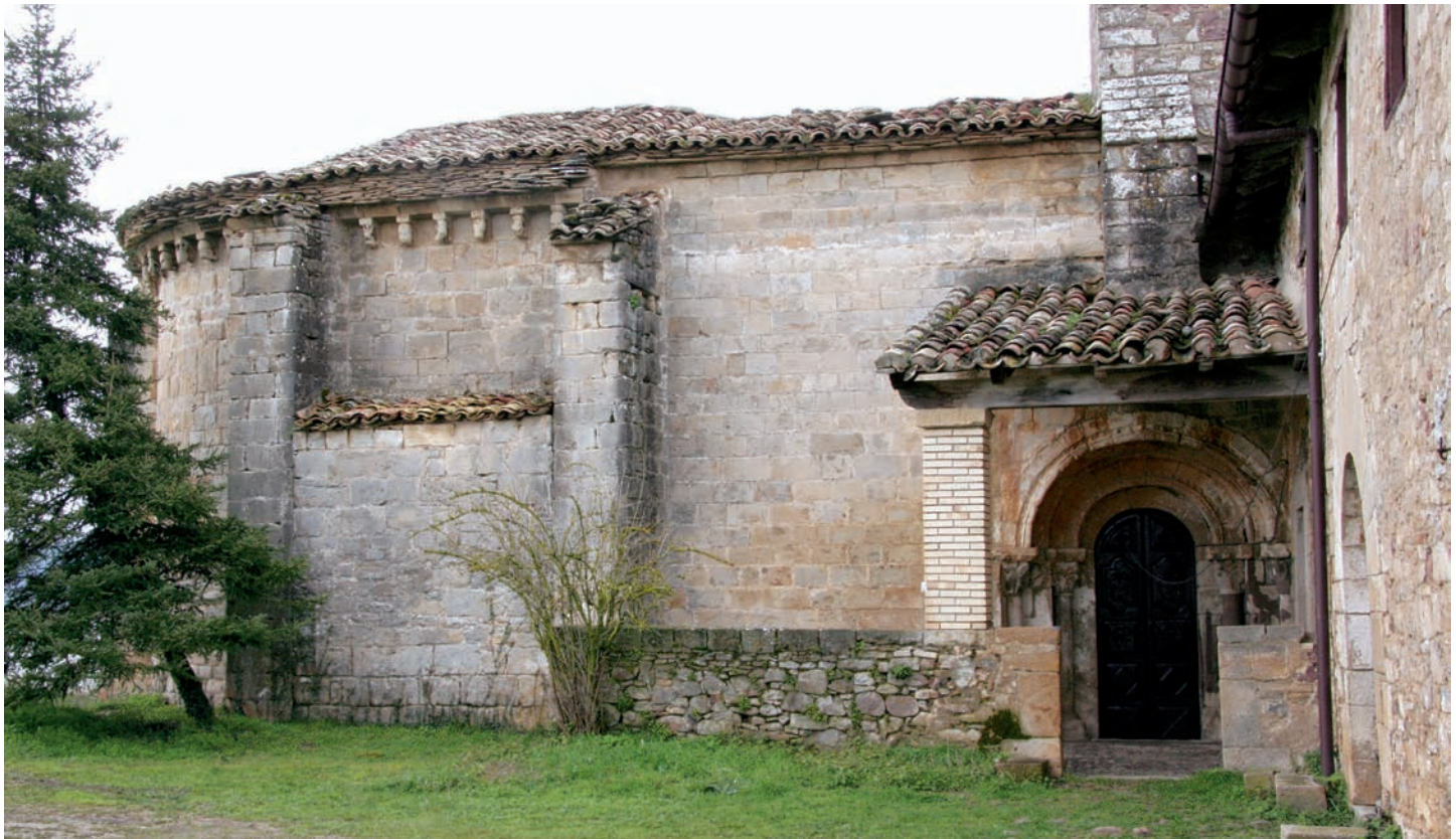
Exterior desde el lado norte
