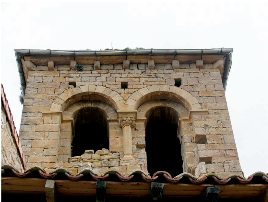
Detalle de la torre
