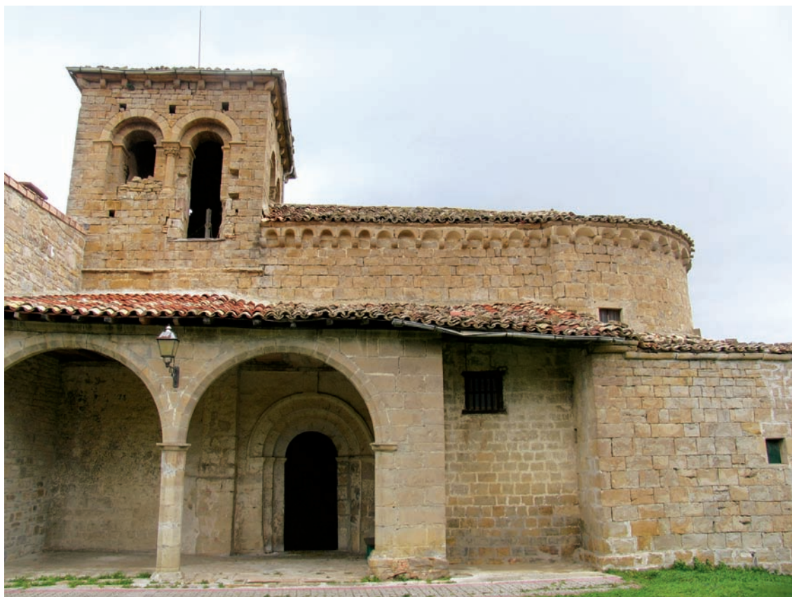
Exterior desde el lado sur
