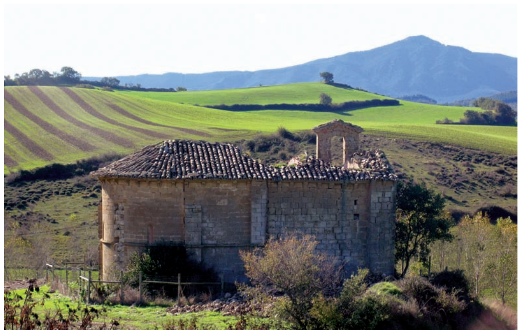
Exterior desde el lado norte
