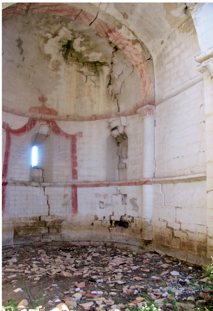
Interior del ábside
