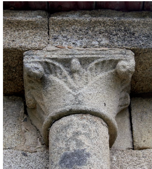
Detalle del muro sur de la cabecera
