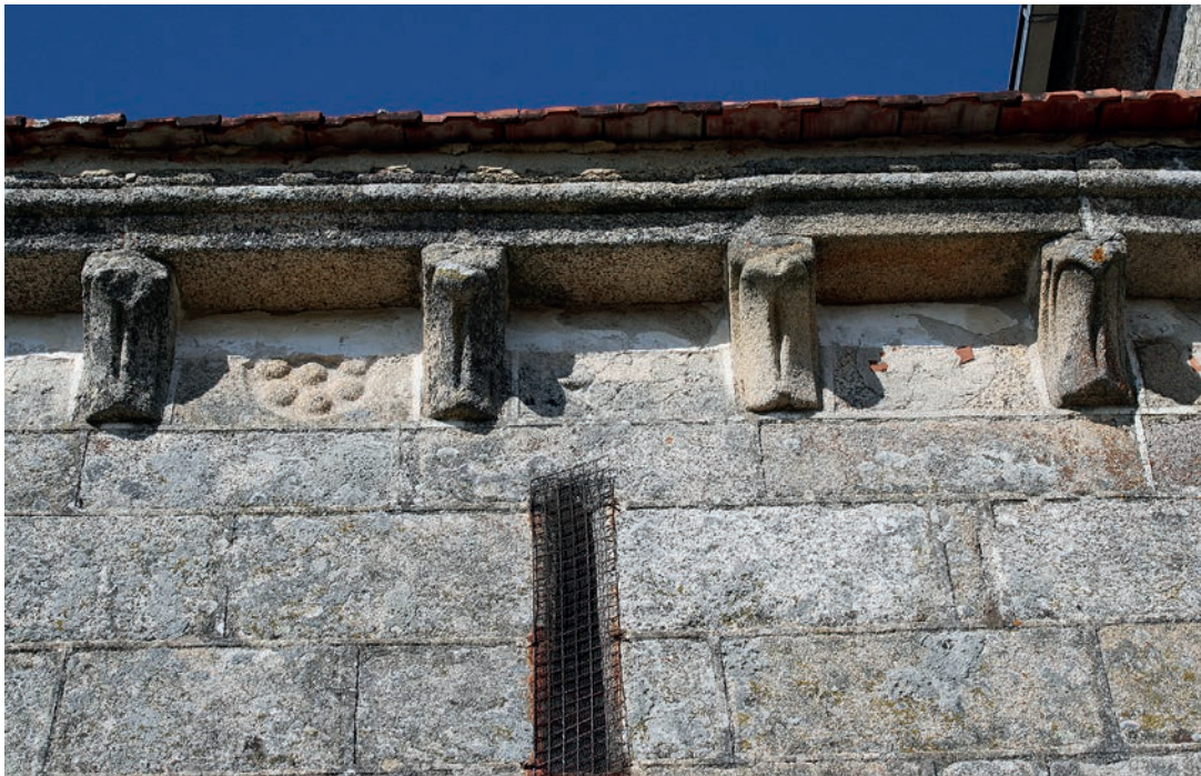
Canchillos del muro sur
