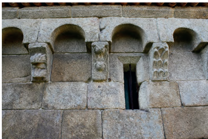
Canecillos del muro sur de la cabecera
