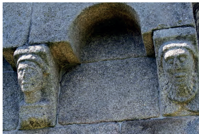
Canecillos del muro sur de la cabecera
