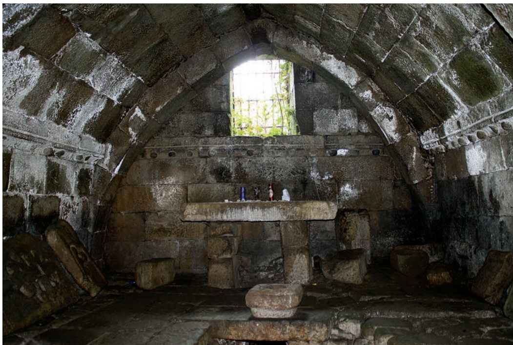
Primer tramo de la cripta
