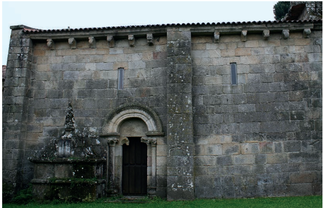
Muro norte de la nave
