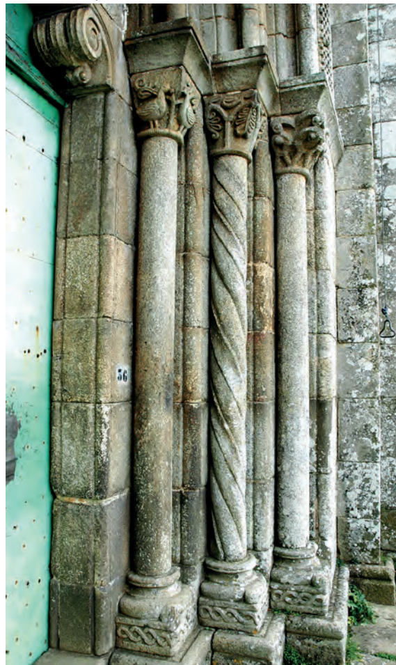
Columnas de la portada oeste
