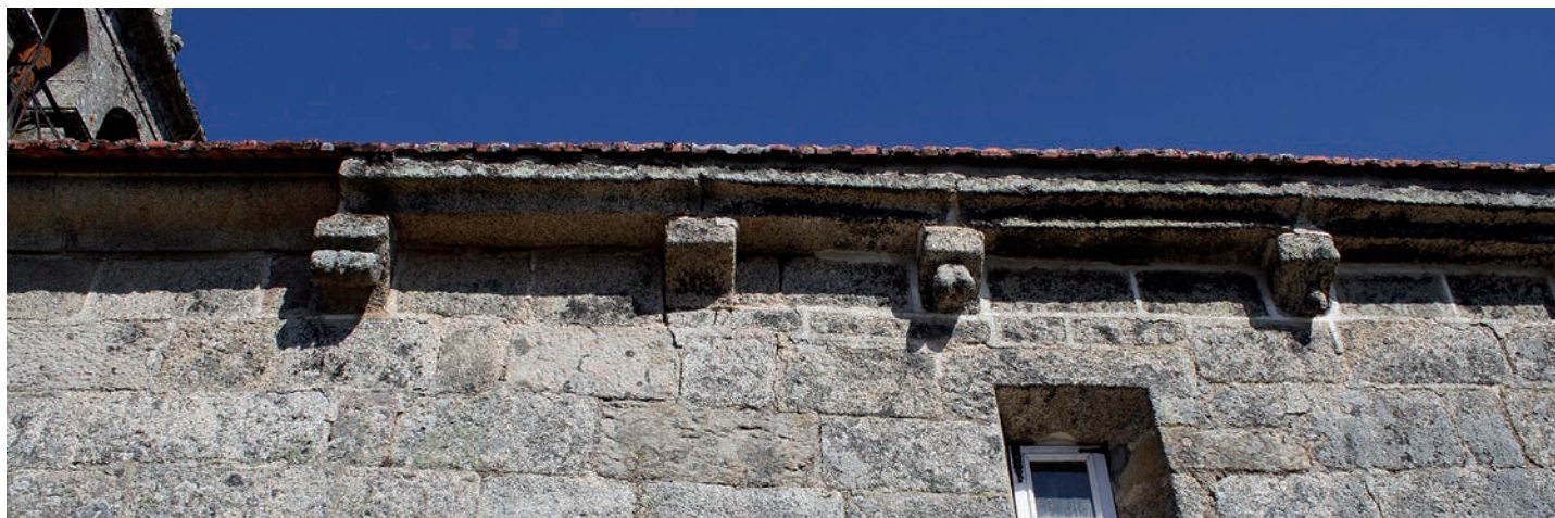
Detalle del muro sur
