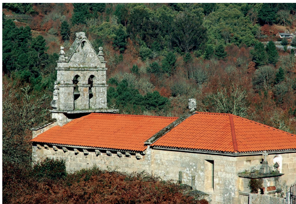
Vista desde el lado sureste
