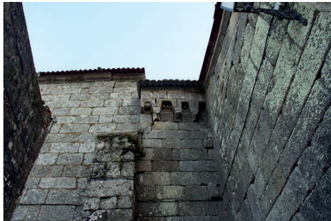
Arquillos del muro norte
