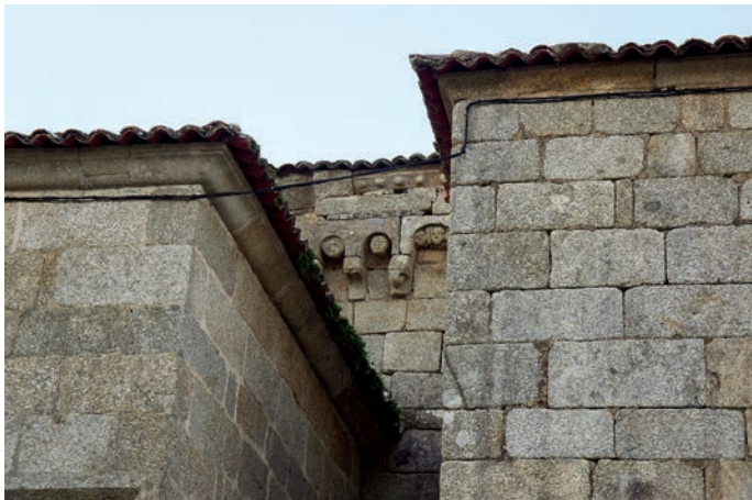
Arquillos del muro sur
