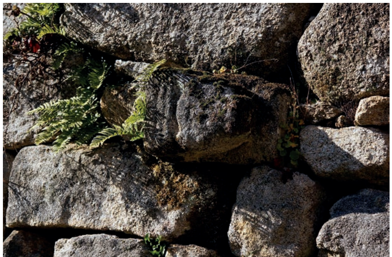
Canecillo reutilizado en el muro de contención exterior
