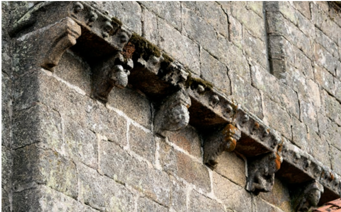
Canecillos del muro oeste
