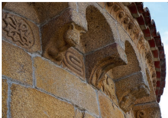
Detalles del coronamiento del ábside
