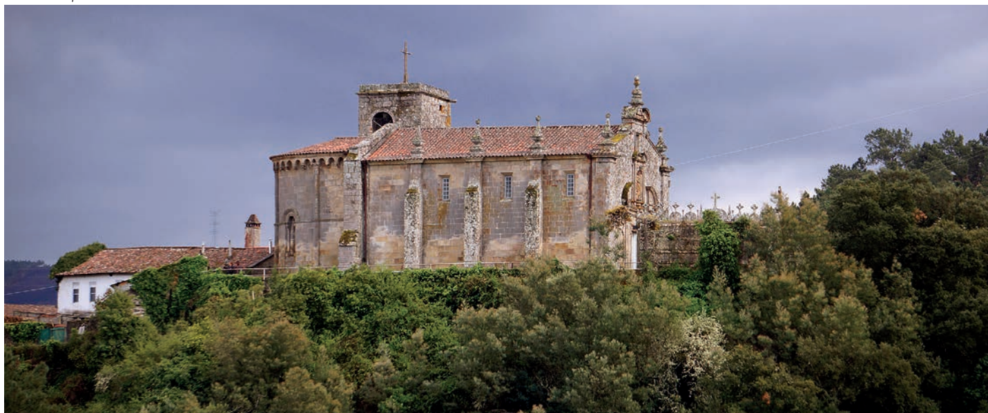
Vista del emplazamiento
