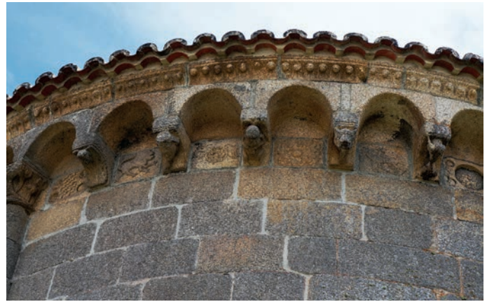
Detalles del coronamiento del ábside
