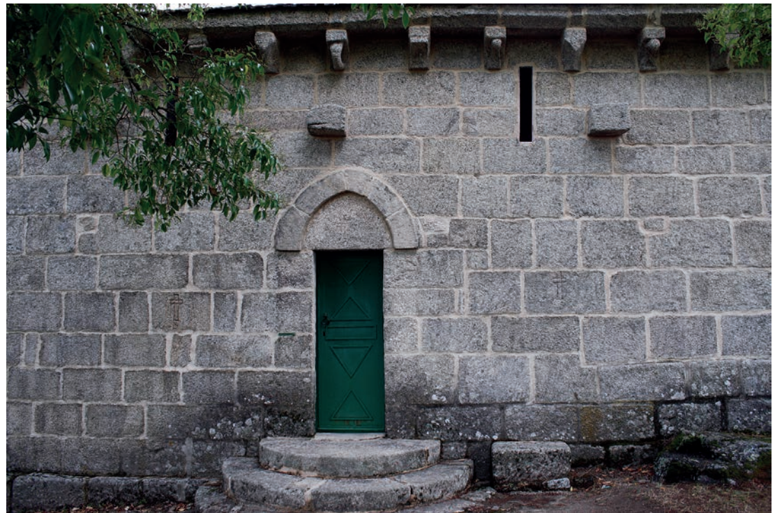
Muro sur de la nave
