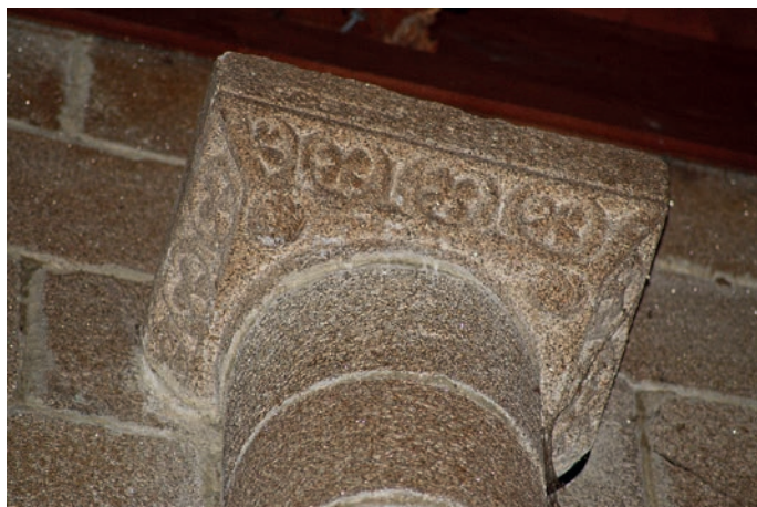
Capitel de la nave
