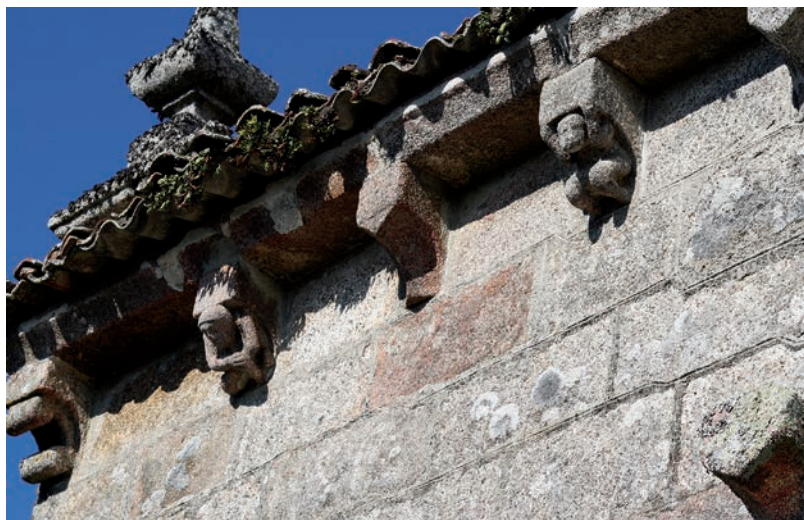
Canecillos del muro sur
