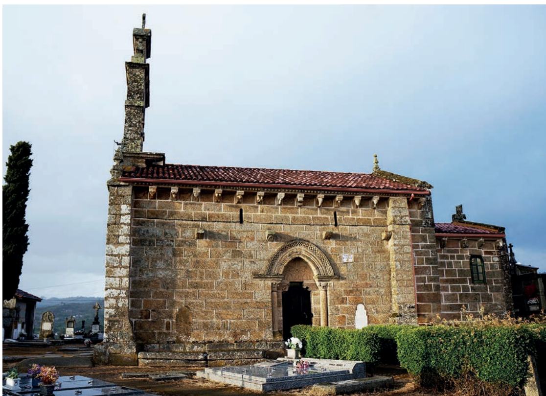
Vista desde el lado sur
