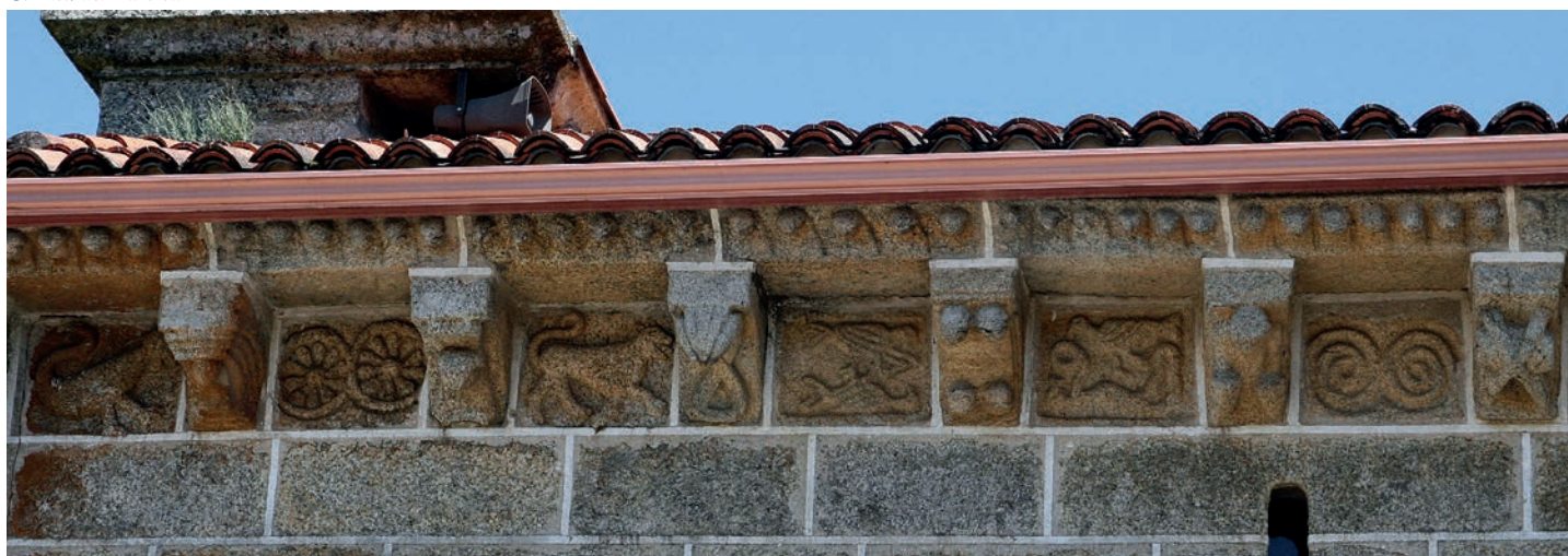
Cornisa del muro sur
