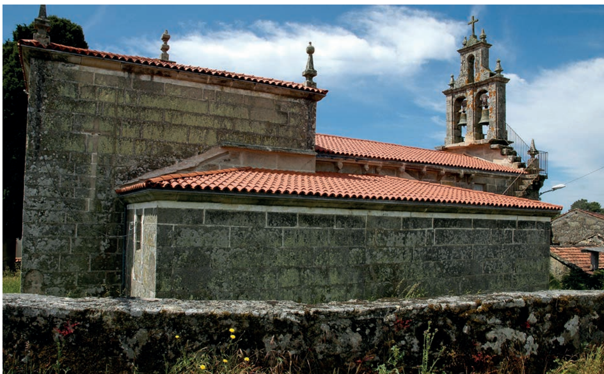
Vista desde el lado norte
