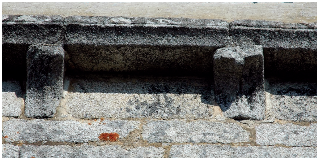
Canecillos del muro sur
