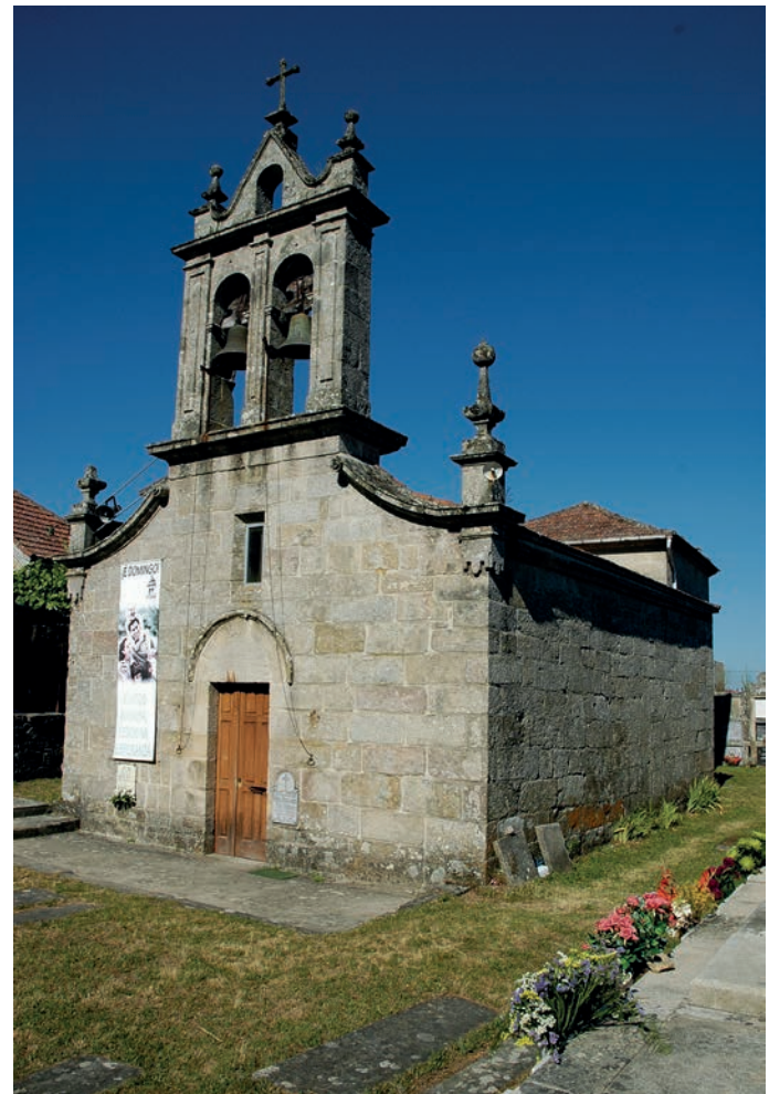
Vista desde el lado suroeste
