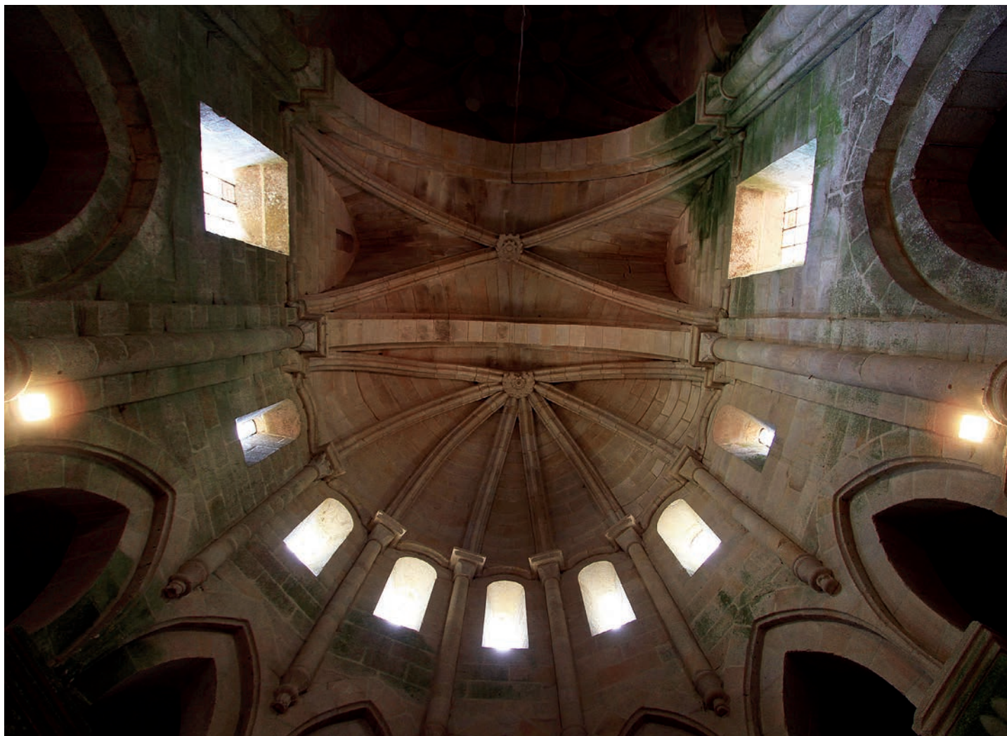
Bóvedas de la capilla mayor
