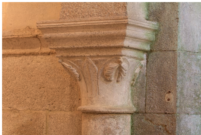
Capitel de la capilla lateral sur de la girola
