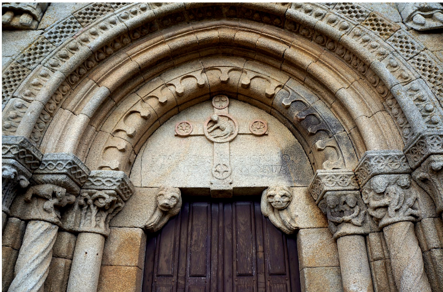
Detalle de la portada oeste
