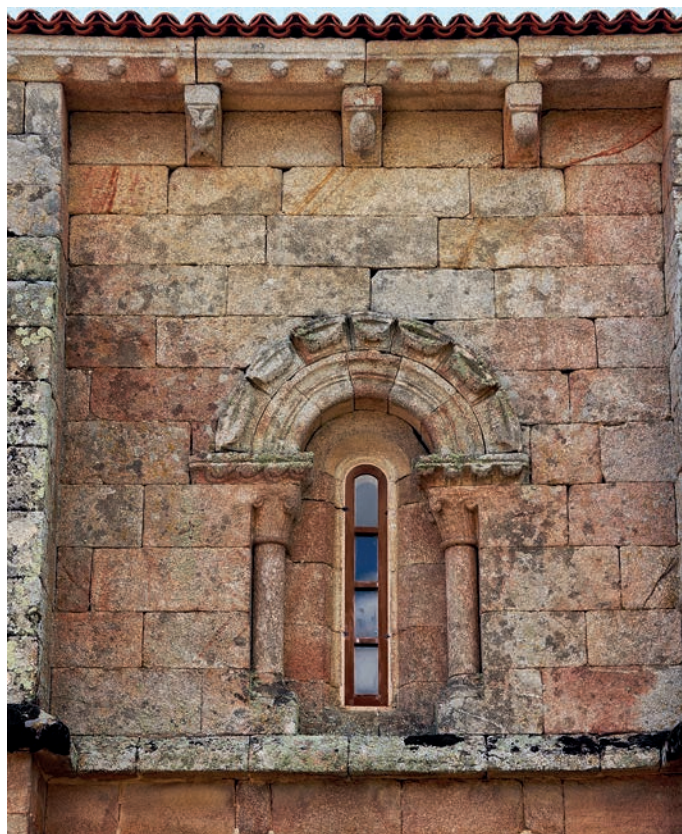
Ventana del muro sur
