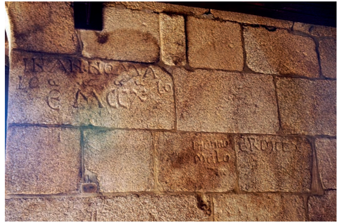
Inscripciones del muro oeste de la nave
