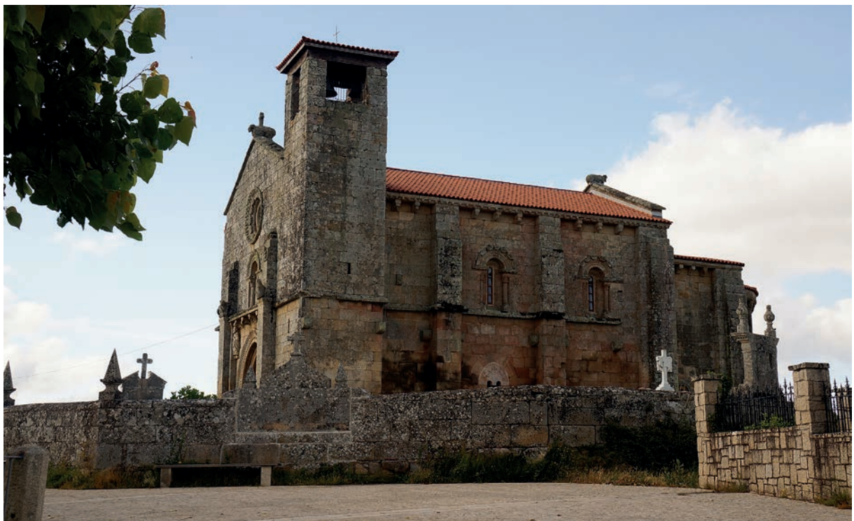
Vista del emplazamiento
