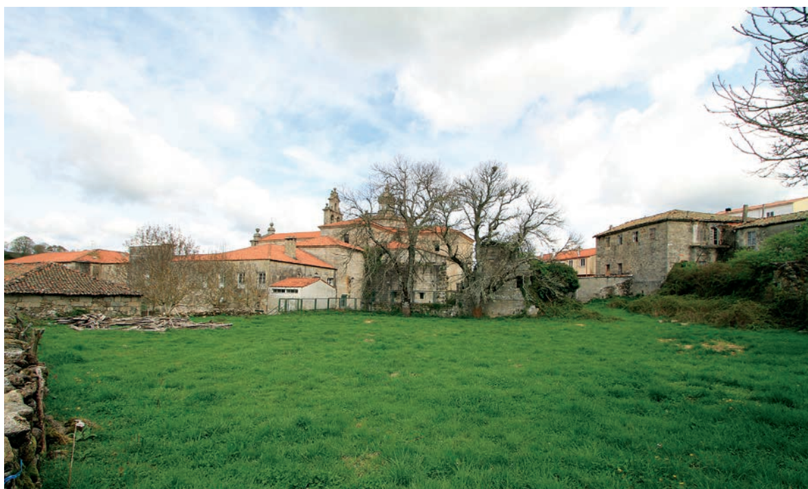
Panorámica del emplazamiento
