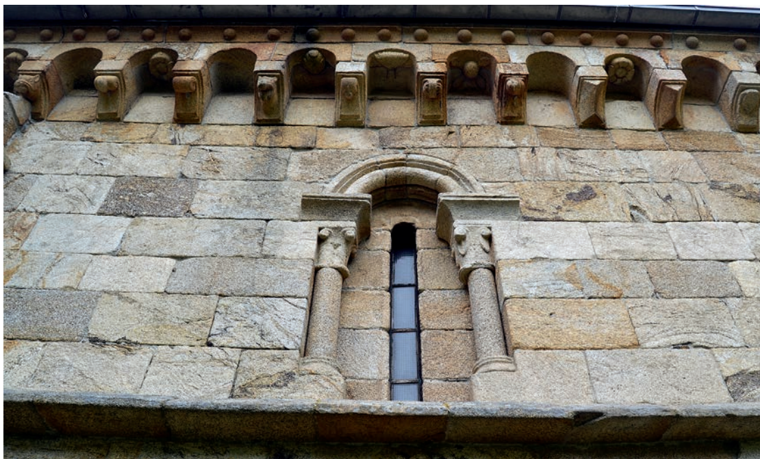
Detalle del muro sur
