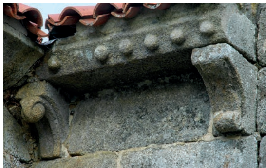
Canecillos del muro sur de la cabecera
