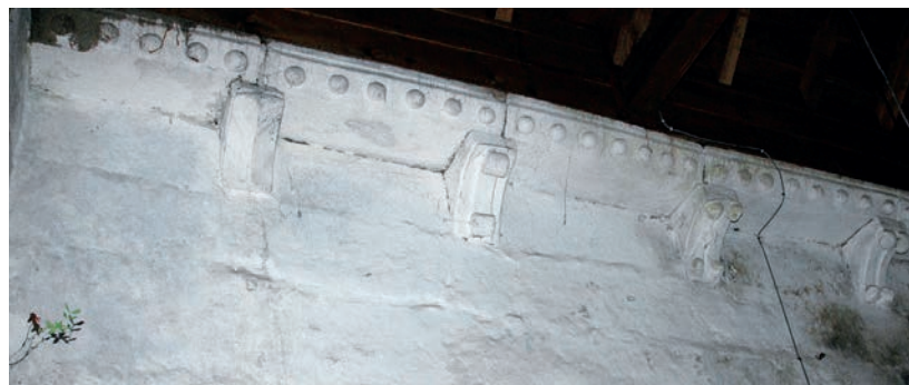
Canecillos del muro sur de la nave
