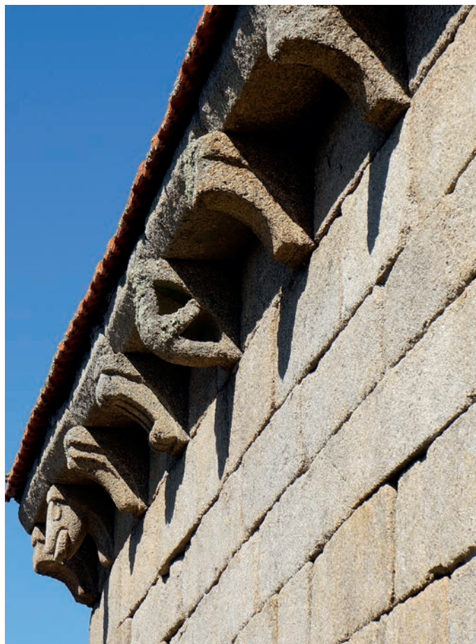
Canecillos del muro sur de la nave
