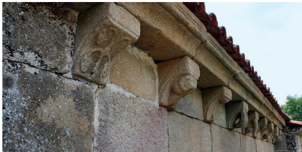
Canecillos del muro norte
