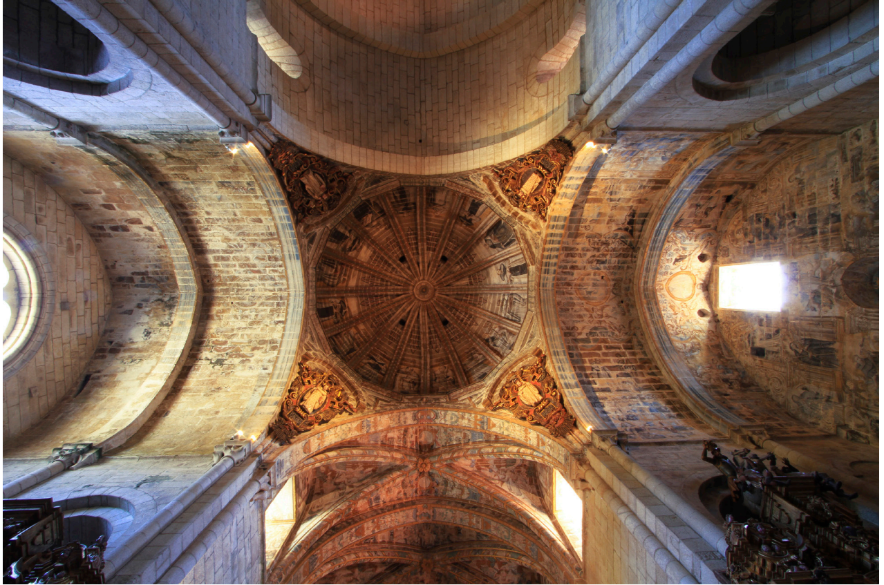
Bóvedas y cúpula del crucero
