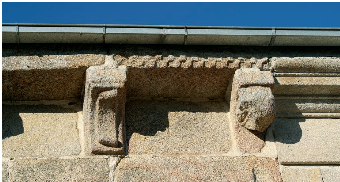
Canecillos del muro sur
