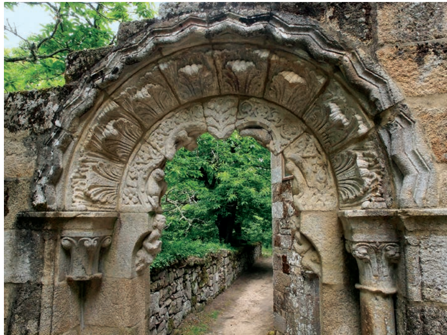
Portada de acceso al claustro
