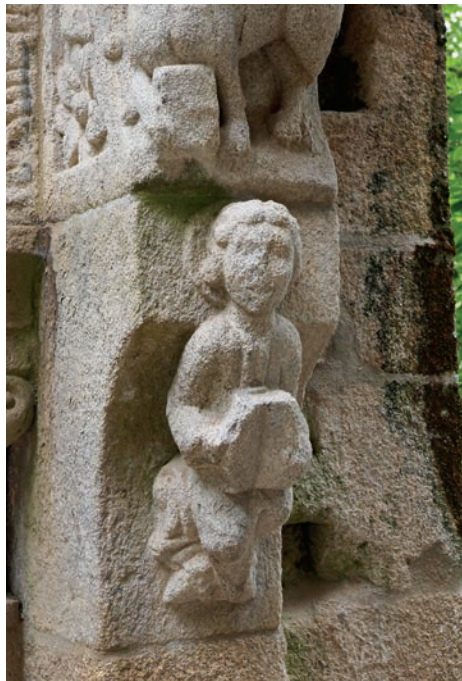
Detalle de la puerta de acceso al claustro
