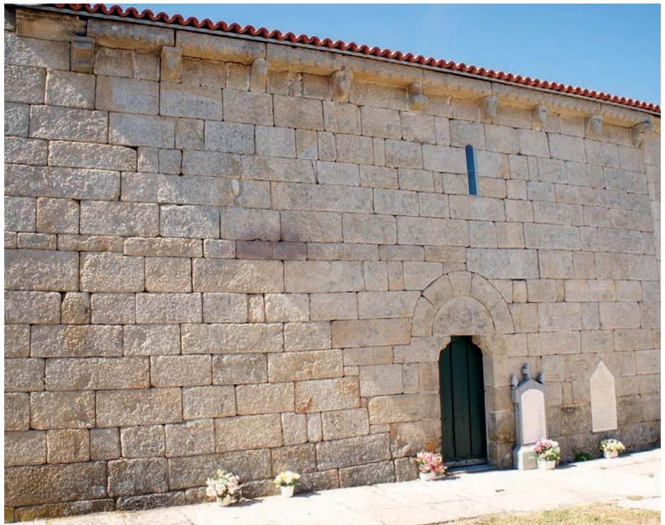
Muro sur de la nave
