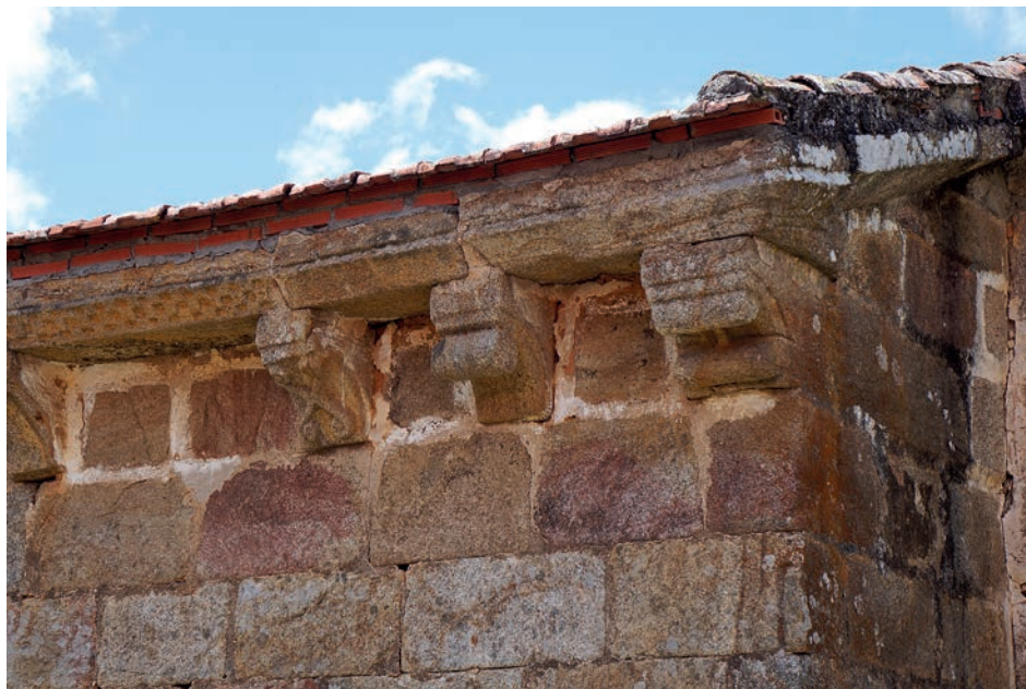
Canecillos del muro sur
